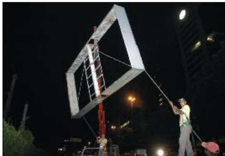
Certains panneaux ont été totalement démantelés mais dans la plupart des cas, les structures métalliques ont été laissées en place et leurs silhouettes squelettiques hantent toujours les rues de la ville.
